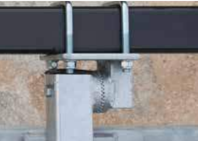
Kantelverstelling met tandschijfsysteem
